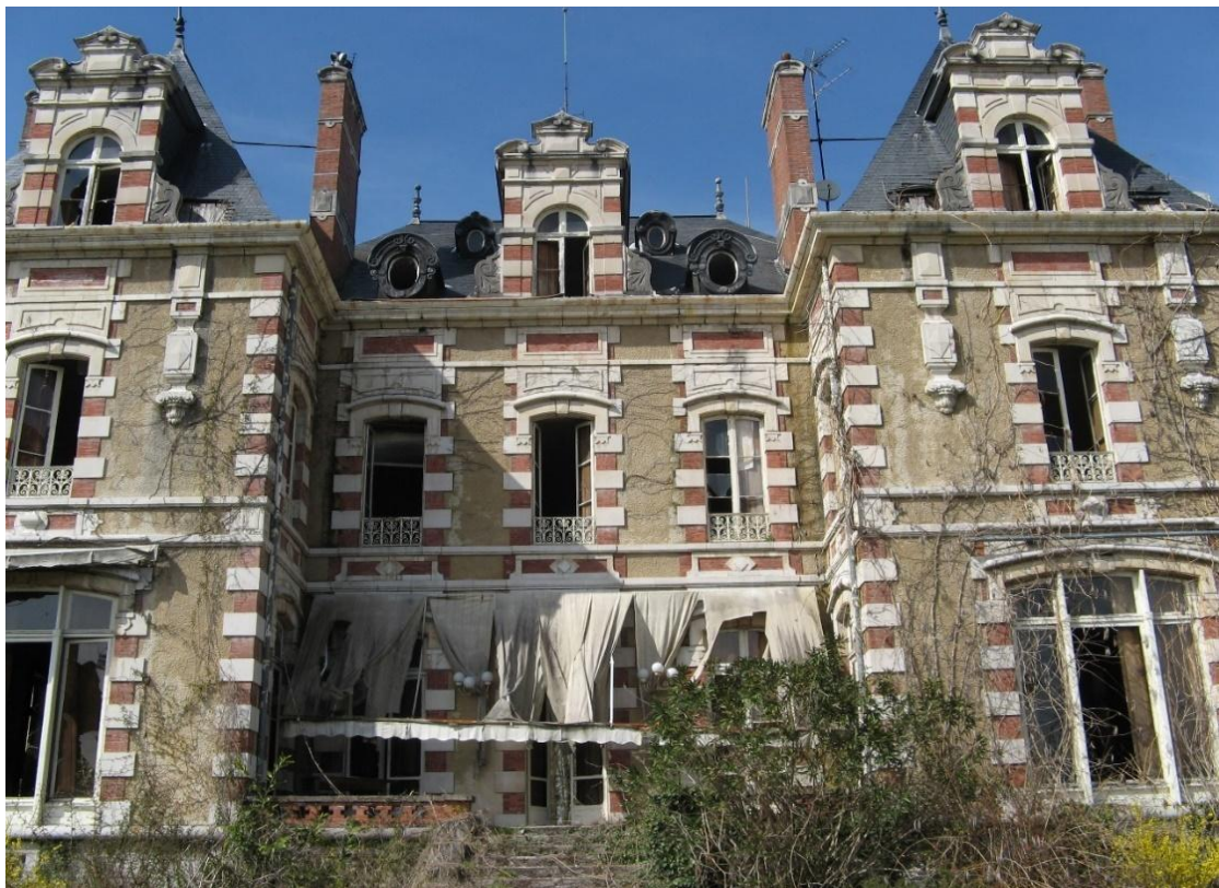
Figure 15 : photographie façade sud extérieure, Château de Mont, CCLO, 2013.
