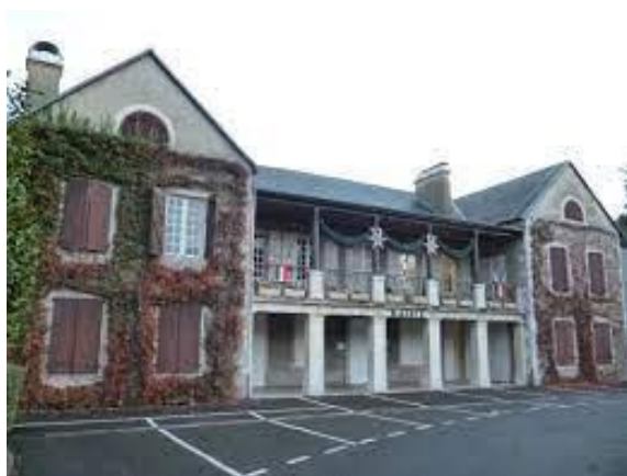
Figure 27 : Hôtel de ville de Mont avant la restauration.
