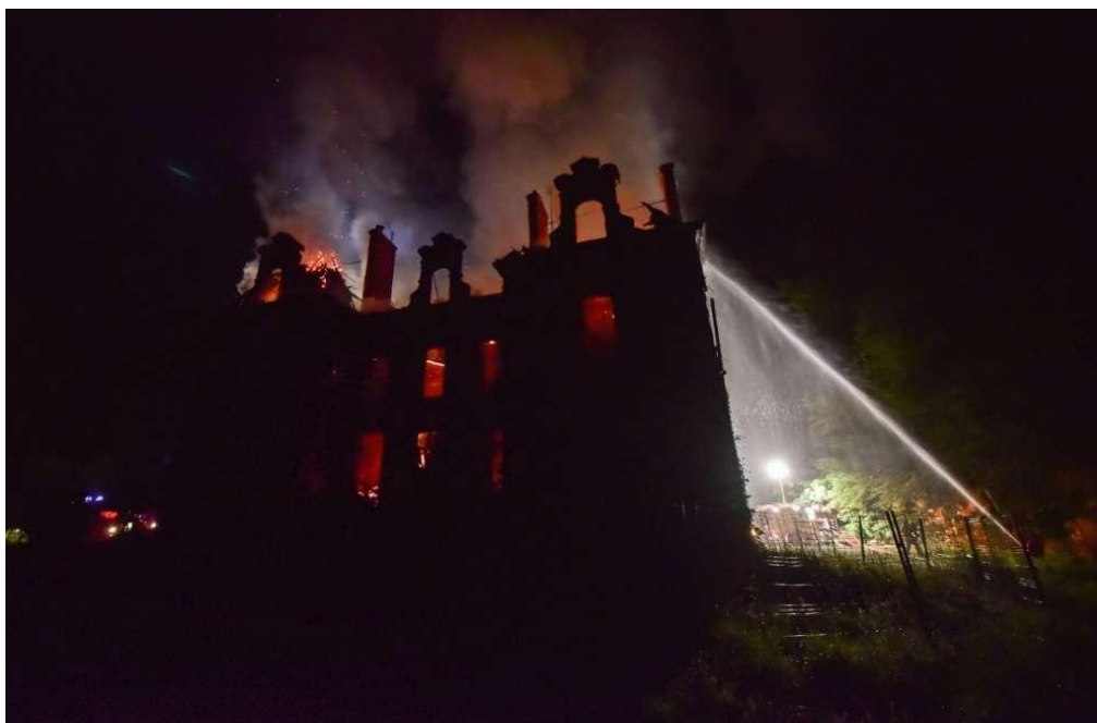
Figure 18 : Photographie de l'incendie du château de Mont, 03 mai 2017.
