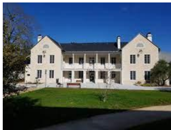
Figure 28 : Hôtel de ville de Mont après restauration.
