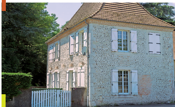
Peinture intérieure d'un logement à Mont ancienne mairie Réception Août 2016
