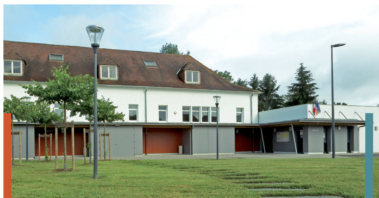
Réhabilitation de la salle des fêtes et création d'une mairie annexe à Arance - Réception : août 2015 Montant des travaux : 279 000 €
