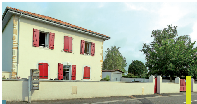
Rénovation complète d'un logement à Arance Réception Décembre 2016
